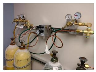
FIGURE 2 MAGELLAN MANIFOLD SYSTEM
