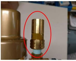
FIGURE 5 PRESSURE RELIEF VALVE (PRV)
