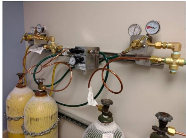
FIGURE 2 MAGELLAN MANIFOLD SYSTEM
